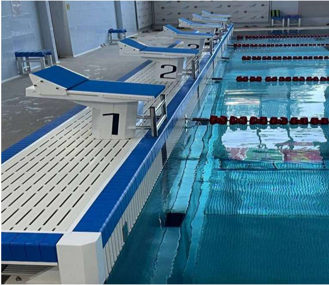
Бассейн «Аквamed» (ул. Высоковольтная, 7а). Новые стартовые тумбы оборудованы устройствами фиксации фальстарта и адаптированы для всех систем хронометража
